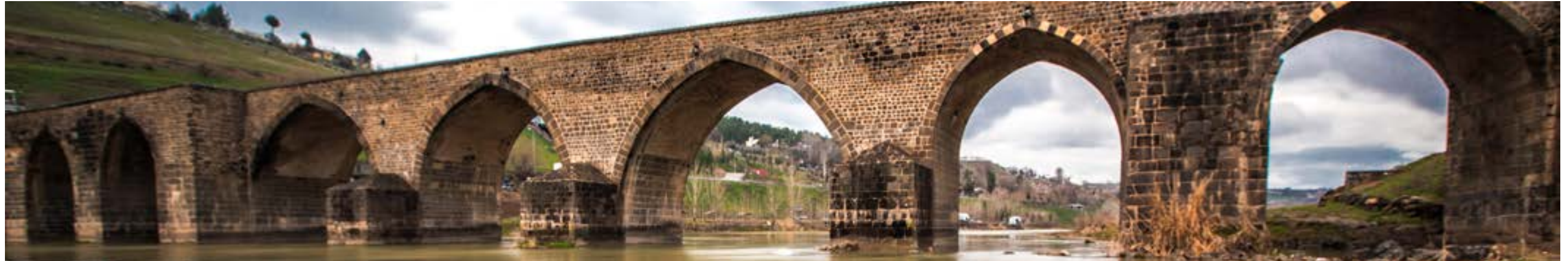
Diyarbakır/ On Gözlü Köprü
