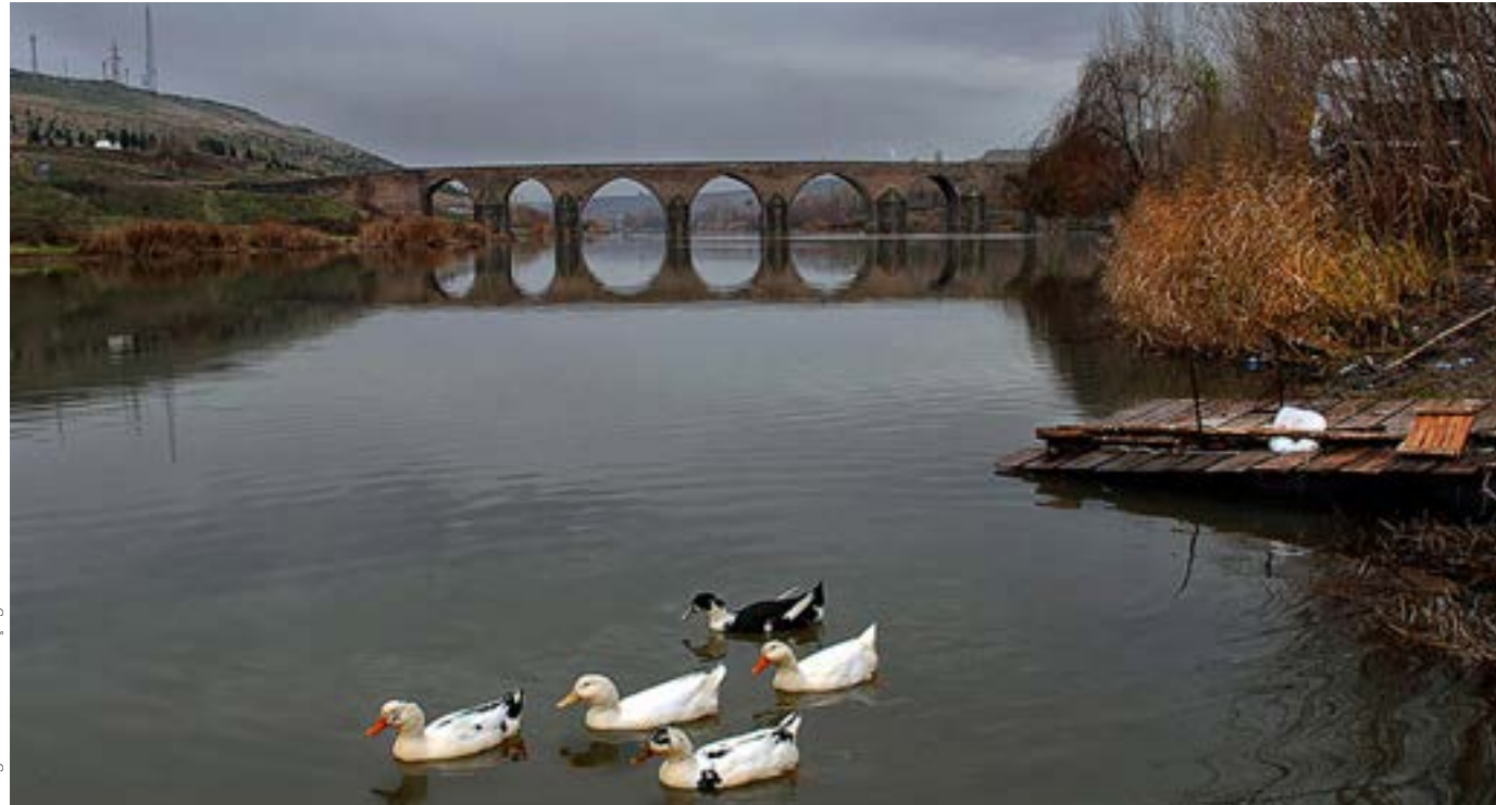
Diyarbakır/On Gözlü Köprü
